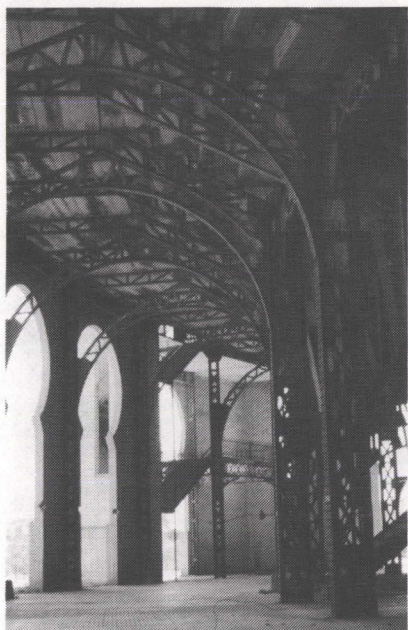
Charpente métallique des arènes de Colonia, en Uruguay
