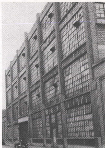
Bâtiment industriel moderne des années '20, à Gand
