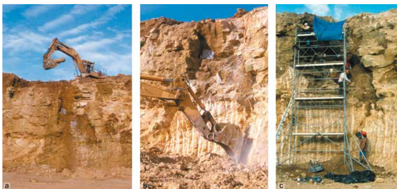
Figure 9 - Sécurisation de la paroi par démontage des blocs désolidarisés par le tir de mine (a), régularisation de la base de la paroi (b) destinée à permettre l'implantation d'un échafaudage (c) (clichés Dominique Cliquet et Jean Barge).
