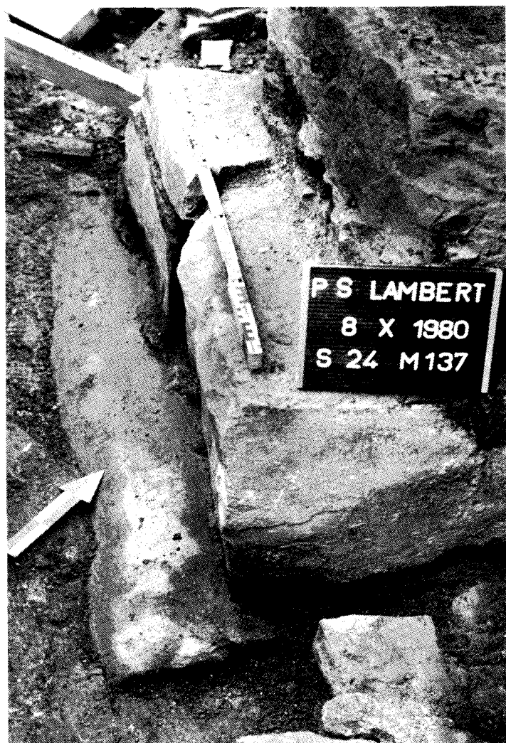
Fig. 72. Colonne (ottonienne ?) réemployée pour border un contrefort gothique.
