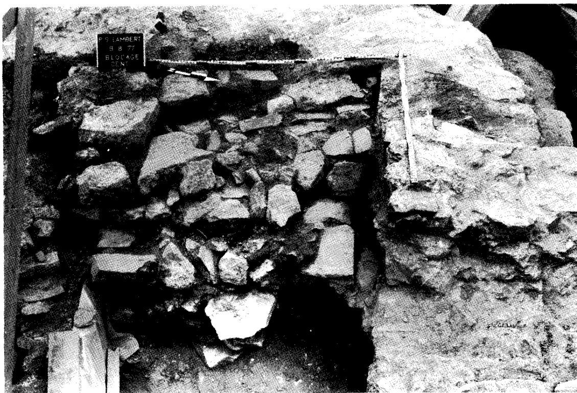
Fig. 68. Blocage de renforcement (M11) non maçonné dans l'angle des murs 9 et 10, antérieurs à l'édifice ottonien.
