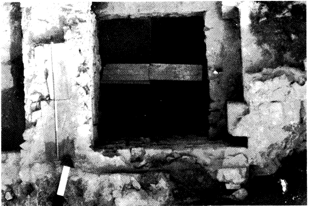
Fig. 53. Nef nord, travée est de la crypte. Sur un mur du chaînage, dalles de béton intégrées au sol; à l'angle, arrachement carré (support ?); sur l'autre mur, base d'un muret est-ouest superposé au béton de sol.
