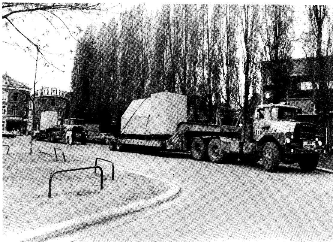
Fig. 7. Transport des éléments par convoi exceptionnel.
