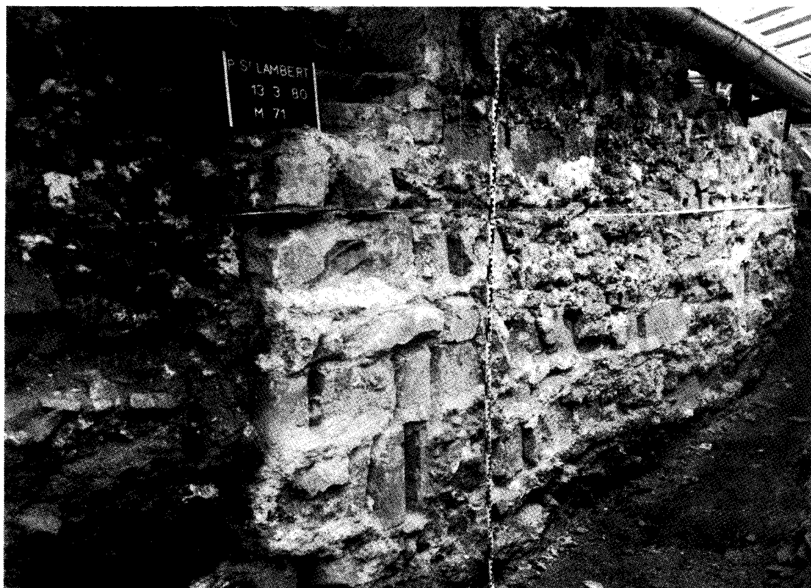
Fig. 155. Mur gothique utilisant des matériaux de remploi.
