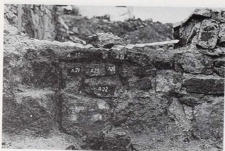
Fig. 100. Numérotation du parement de la crypte avant démontage.
