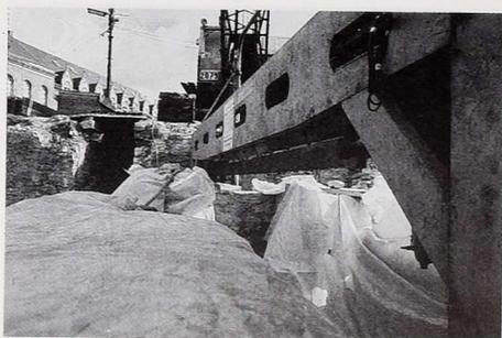
Fig. 101. Sciage d'un mur romain.
