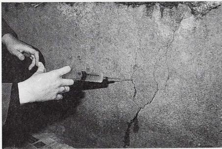
Fig. 93. Imprégnation des enduits fissurés à la seringue.
