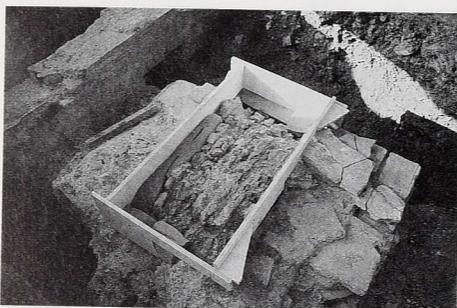
Fig. 98. Fabrication d'un coffrage de maintien.
