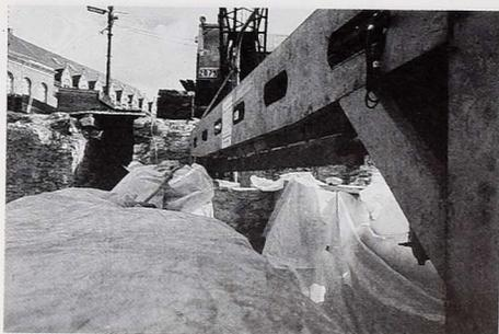
Fig. 101. Sciage d'un mur romain.
