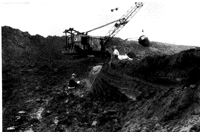
Fig. 5.1-1 La découverte des premiers vestiges blicquiens, en cours de destruction.
