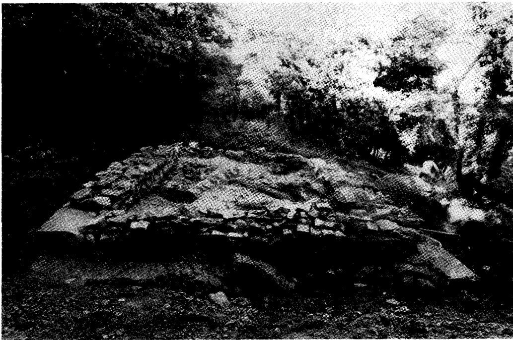
FIGURE 6 b — Bâtiment religieux sur éperon rocheux orienté nord-sud. Longueur : 9.50 m, largeur : 6 m. Vue vers le nord.
