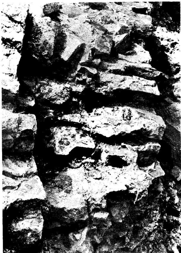
FIG. 3. La photo montre en coupe le mur semi-circulaire intérieur de l'abside s'appuyant sur les fondations du mur extérieur.
