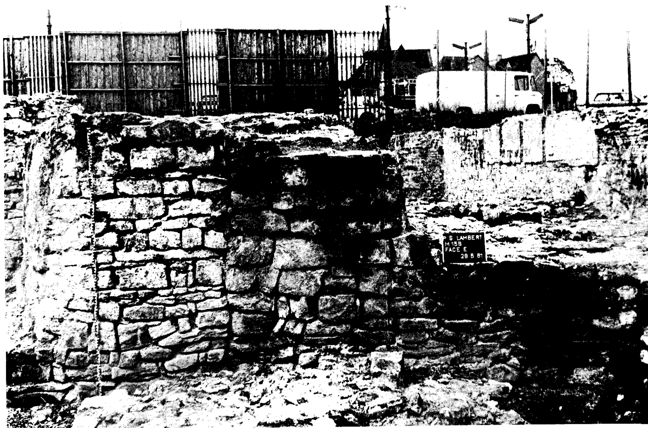
FIG. 5. Phase D : Rhabillage extérieur de la crypte.
