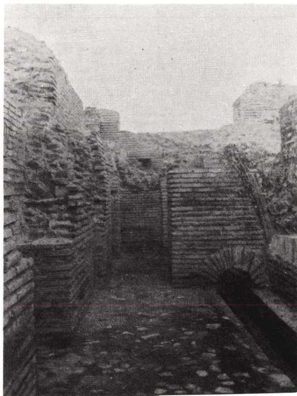
Fig. 28 : Couloir de service des « grands thermes du nord » - Timgad* (DZ).
