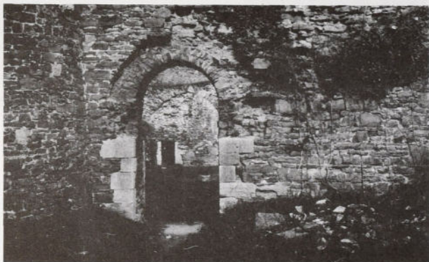
Figure 36 Contrefort, appuyé au donjon, percé d'une porte et barrant la basse-cour est. 1944. © A.C.L., Bruxelles.
