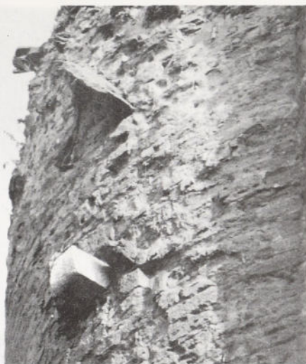
Figure 16 Détail de la tourelle nord-est du donjon. P.H., 1976.
