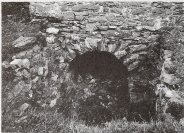
Figure 23 Sortie de la fosse de la tour à latrines de l'aile nord. 1944. © A.C.L., Bruxelles.
