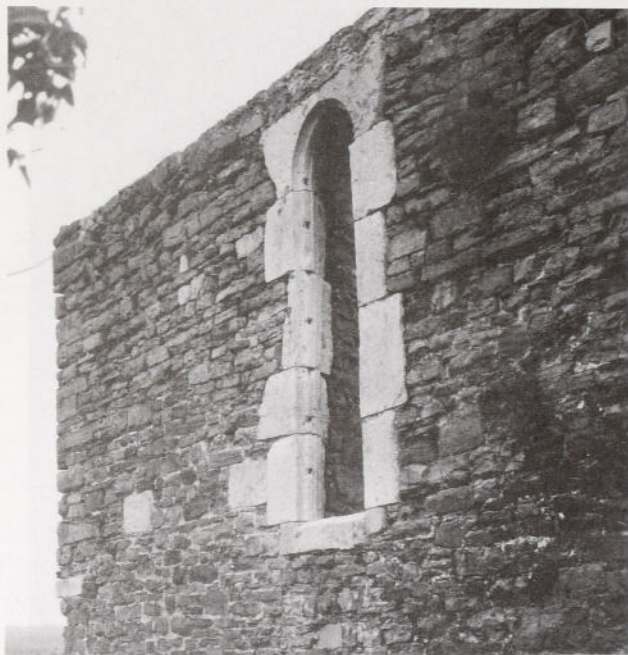
Figure 34 Fenêtre de la façade est de la chapelle. 1944. © A.C.L., Bruxelles.
