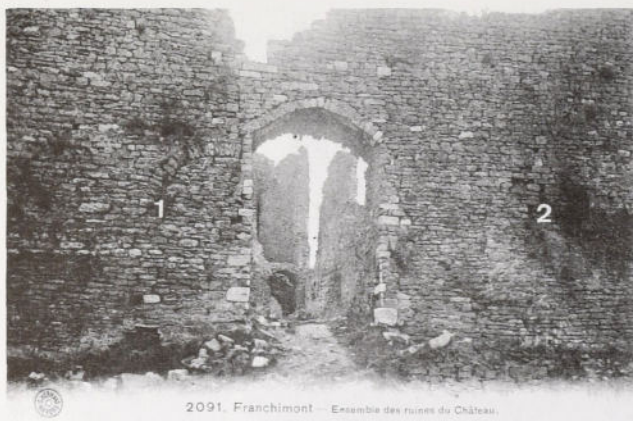
Figure 28 Porche de la haute-cour vu depuis la basse-cour ouest. Ancienne carte postale.
