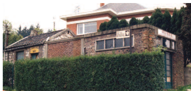
FIG. 4 Vue de l'ancien musée, rue des Chercheurs de Wallonie, à Flémalle, avant sa destruction en janvier 1996.
