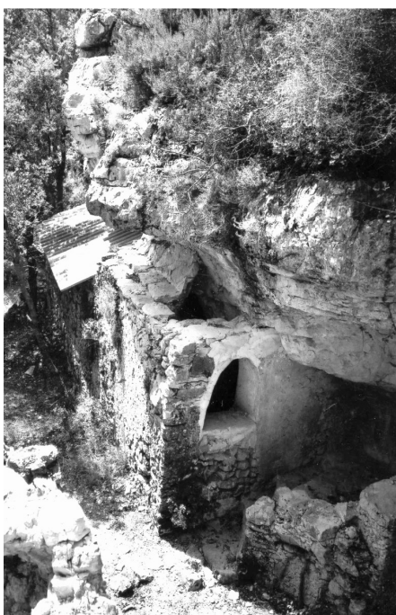
Figure 67 – La citerne alimentée par une fissure de l'entablement rocheux vue générale et détail des dalles redressées.
