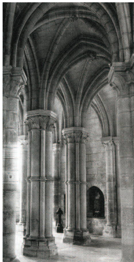
Figure 5. Soissons, cathédrale, supports à l'entrée de la chapelle oblique du bras sud du transept.
