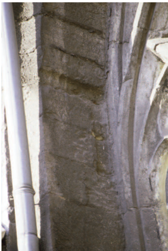
Figure 13. Liège, cathédrale Saint-Paul, nef, façade nord, cavités creusées dans l'embrasure des baies du vaisseau principal. À gauche: ébrasement de gauche. À droite: ébrasement de droite.
