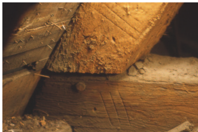
Figure 4. Marques d'assemblages relevées dans la charpente de la nef de l'église Saint-Paul.
