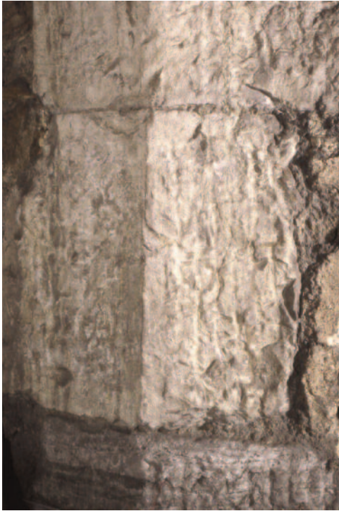
Figure 10. Liège, paroissiale Sainte-Croix, anciennement collégiale, angle de la tour: calcaire de Meuse, taille à la broche verticale.
