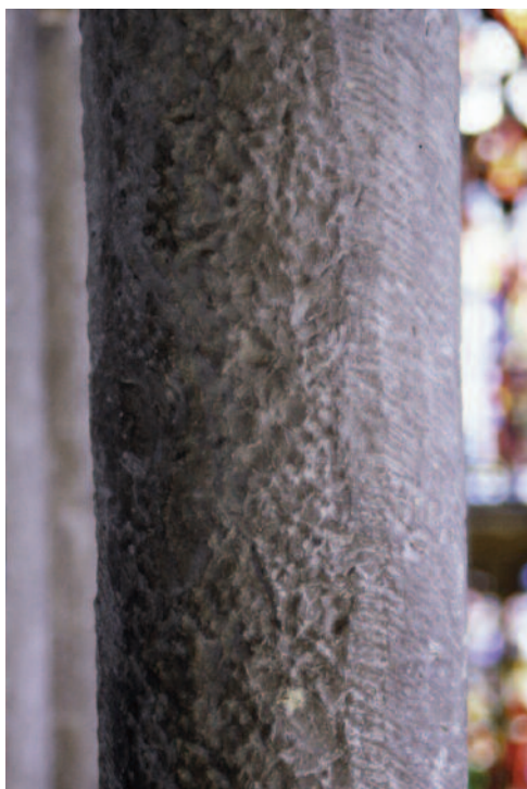
Figure 12. Liège, cathédrale Saint-Paul, colonnette inachevée du triforium, calcaire de Meuse: taille à la broche et taille au ciseau.
