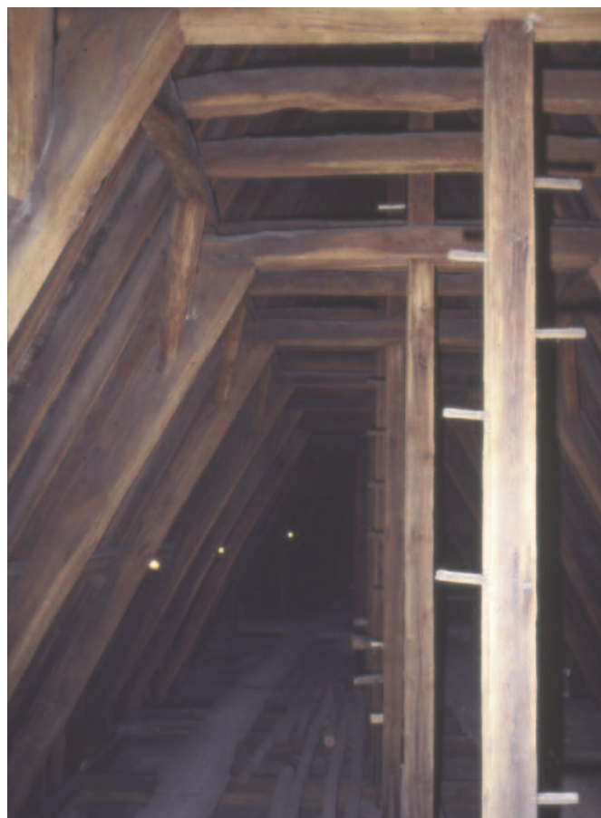
Figure 2. Charpente de la nef de l’église Sainte-Croix, avec marques d’assemblages.
