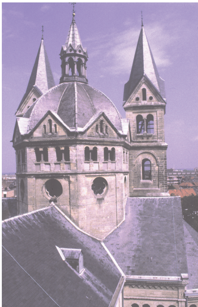
Figure 3. Roermond, coupole de la croisée et deux tours flanquant le sanctuaire (© THOC, juin 2000).
