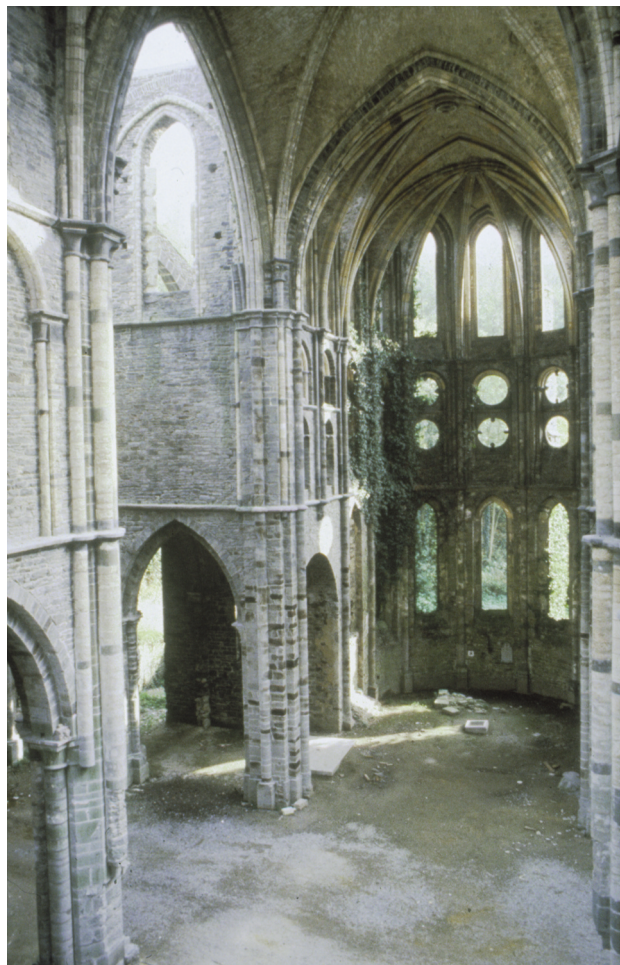
Figure 2. Villers, croisée et abside de l'église III B (© THOC, octobre 1988).
