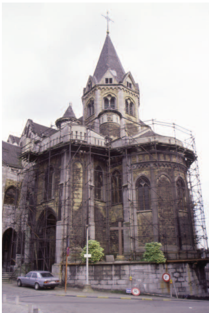
Figure 8. Liège, collégiale Sainte-Croix, partie occidentale, premières décennies du XIIIe siècle.
