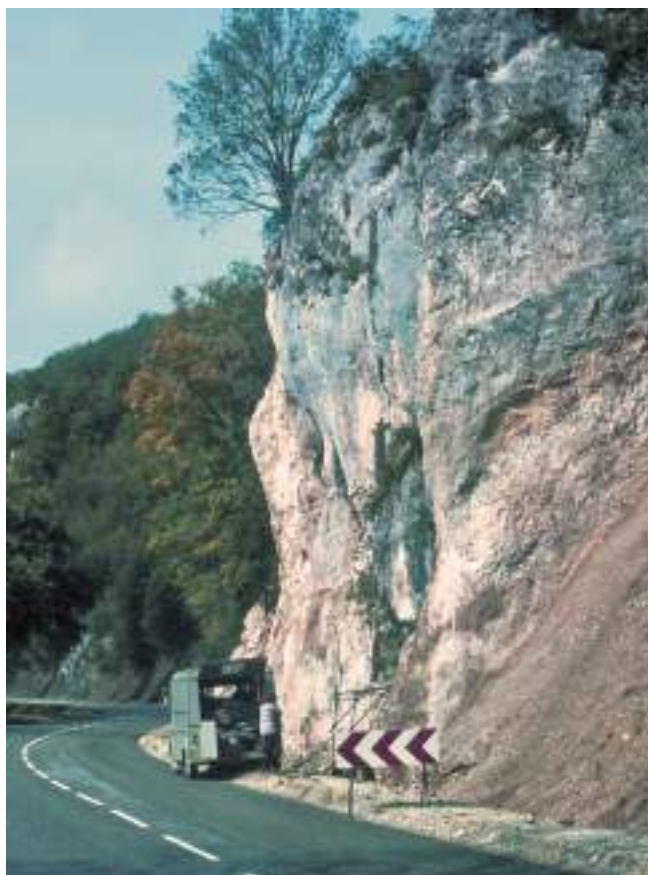
Photo 1. Vue du site en pied de falaise.
