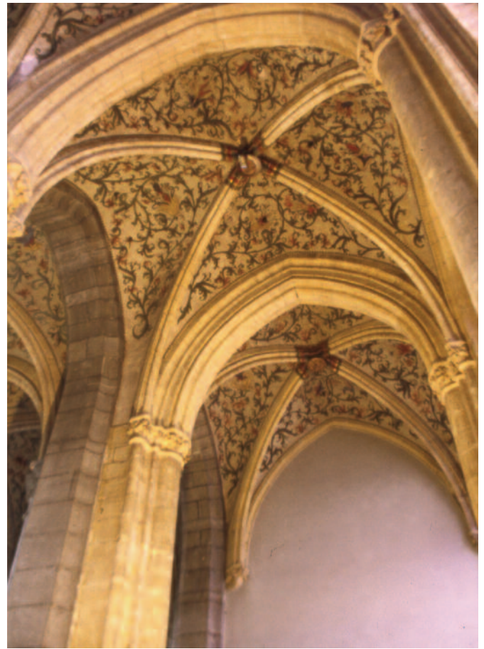
Figure 7. Liège, cathédrale Saint-Paul, chapelles latérales septentrionales de la nef: calcaire lorrain pour les arcs et les nervures de voûte.
