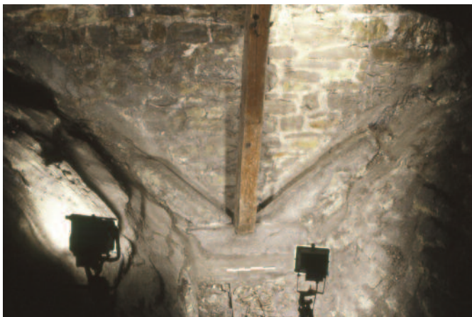
Figure 14. Liège, cathédrale Saint-Paul, comble du transept, mur est: chéneaux en pierre sur les formerets des voûtes.
