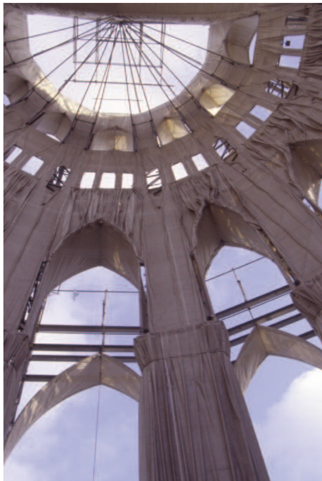
Figure 2. Liège, reconstitution du chœur de la cathédrale Saint-Lambert par une structure de métal et de la toile, été 2000 (© In Situ – MRW, Division du Patrimoine. Photo: Ph. Géron).
