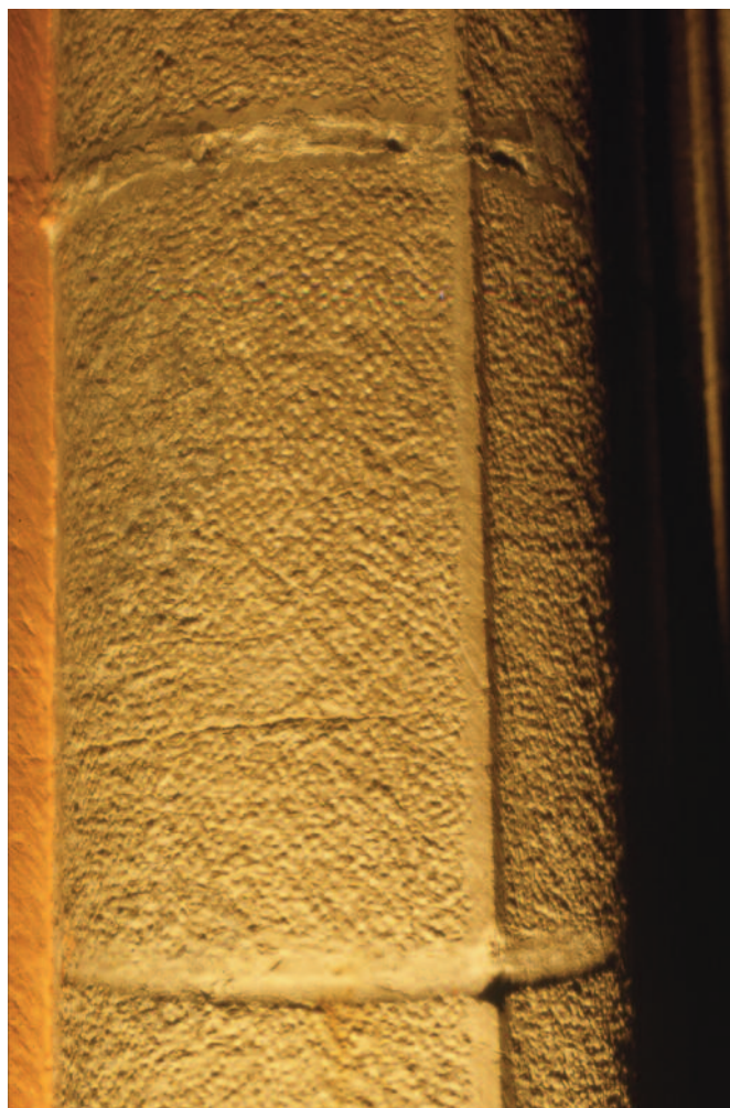
Figure 9. Liège, cathédrale Saint-Paul, colonnette dans le chœur, calcaire de Meuse, taille fine à la broche, palette au ciseau.
