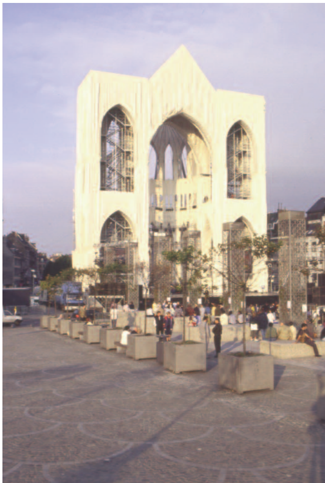
Figure 1. Liège, reconstitution du chœur de la cathédrale Saint-Lambert par une structure de métal et de la toile, été 2000 (© In Situ – MRW, Division du Patrimoine. Photo: Ph. Géron).
