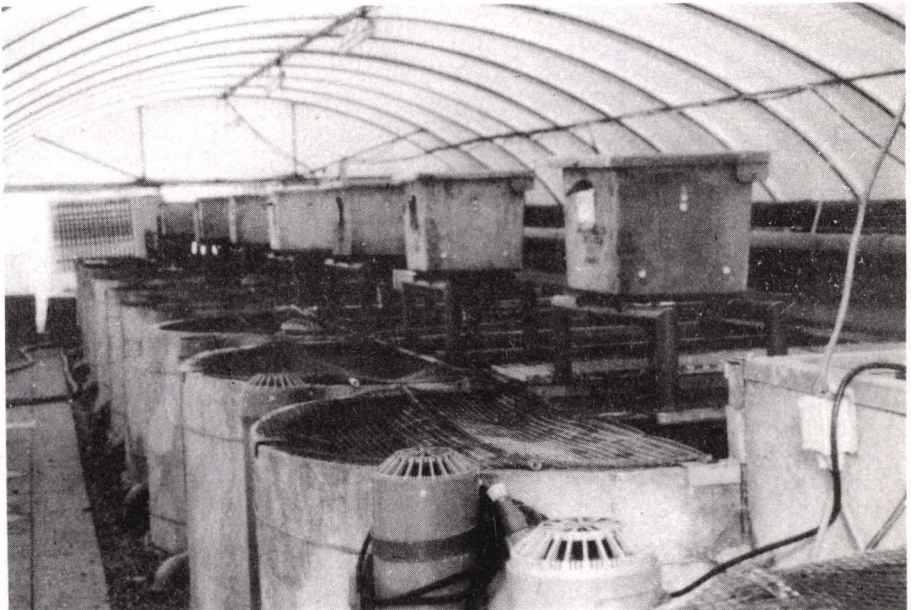
PHOTO 8 : Installation pilote de production commerciale du tilapia à Tihange (S.A.R.L. TATE & LYLE).
