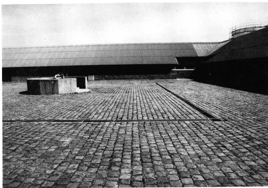
Photo 4. Cour intérieure de la ferme, Station de Zootechnie de la Faculté de Médecine vétérinaire. Celle-ci est en passe d'achever son transfert de Cureghem, en périphérie bruxelloise, sur le campus du Sart Tilman, dans la périphérie boisée de Liège. Les services de Virologie, Immunologie, Epidémiologie; d'Analyse des denrées alimentaires; de physiologie des animaux domestiques; la station de zootechnie; les services de chirurgie et de clinique des grands animaux y sont déjà rassemblés. L'ensemble sera un des plus modernes d'Europe.
